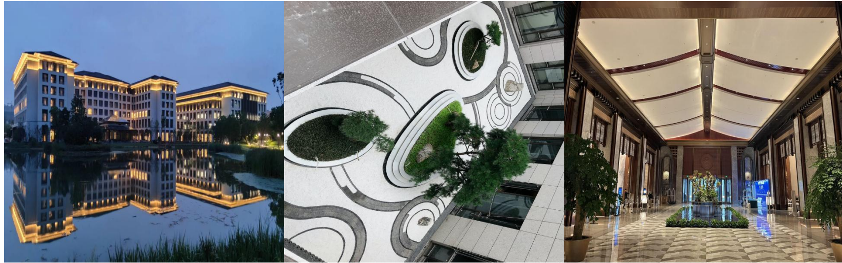
项目 7：皇粮浜地块改造项目 1#房及地下车库建筑工程施工总承包
