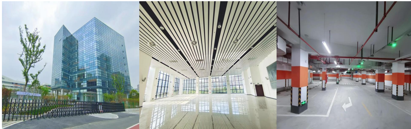
项目 6：新堂北路南侧、新一路西侧（QL030215）地块建筑工程施工总承包
