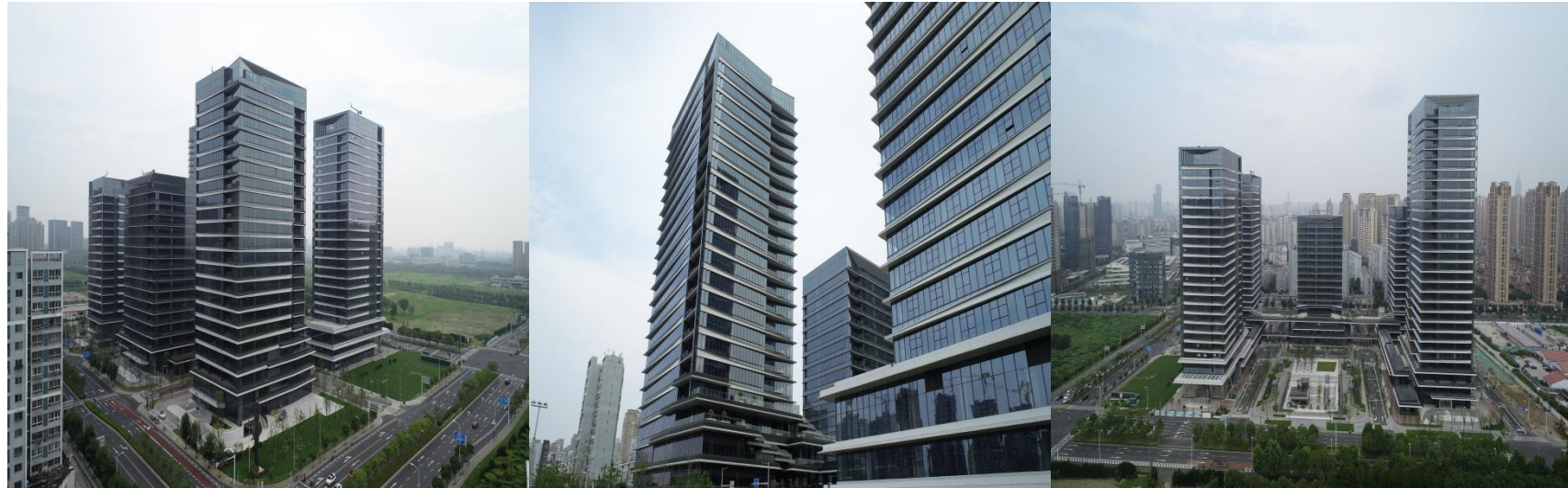
项目 7-2：常州金融商务区金融广场（一期）（QL-030321-1、-2、-3、-4、-5 地块）项目 2#楼建筑幕墙及 1#-2#连廊雨棚分包工程
