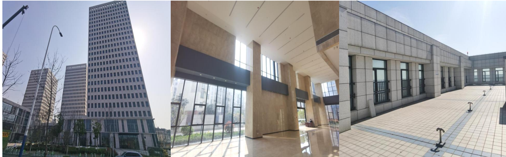
项目 9：江苏联创钟楼国际软件园一期工程（百度大数据产业园（暨常州联创金陵项目）一期工程）1#楼、2#楼、3#楼、裙房及地下室工程
