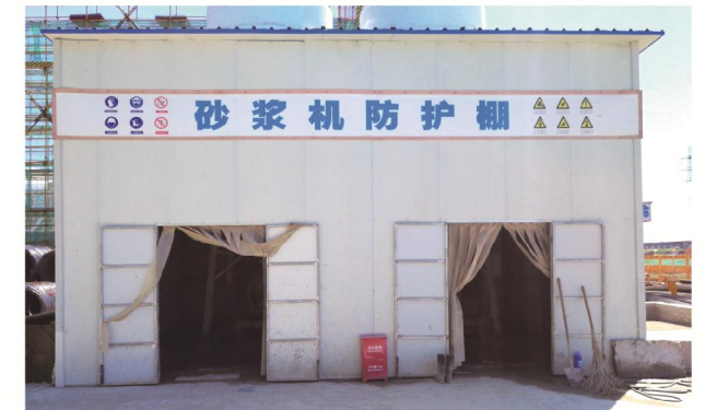
预拌砂浆搅拌棚防尘围挡
