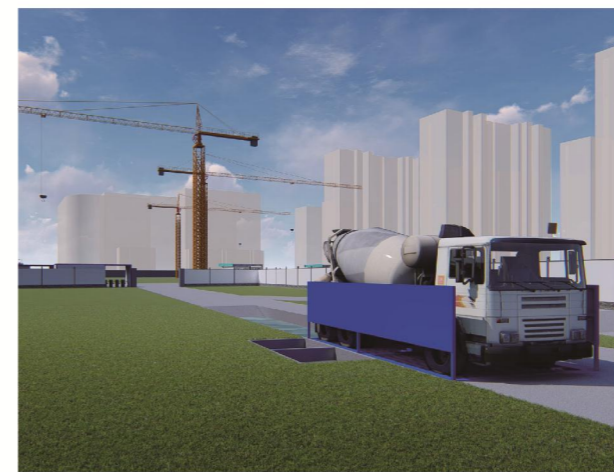
过水池+自动冲洗平台
