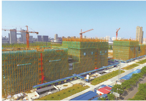
钢管扣件架体、阻燃密目安全网围蔽
