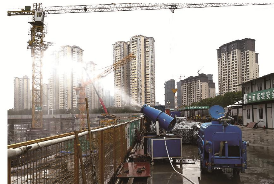
作业区雾炮设置
