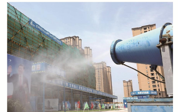
作业区雾炮设置
