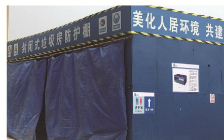
建筑垃圾防尘收集池
