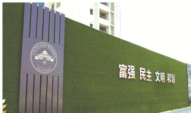
型钢立柱、彩钢板墙体、仿真绿植
