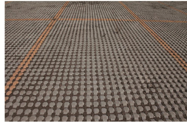
停车场地预制水泥草坪砖铺装(可回收)
