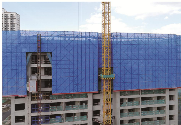
型钢爬升脚手架架体、钢板网片围蔽
