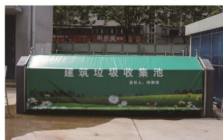
建筑垃圾防尘收集池
