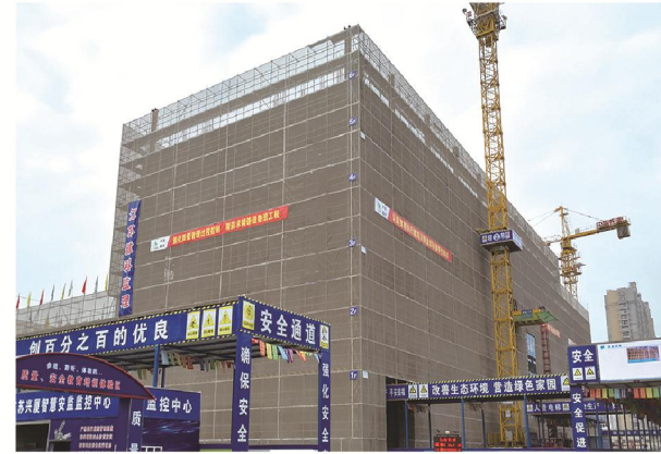
销键型脚手架架体、阻燃密目安全网围蔽
