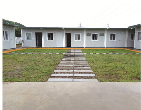
预制钢筋混凝土道板(可回收)+绿化
