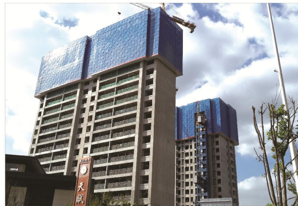
型钢爬升脚手架架体、钢板网片围蔽
