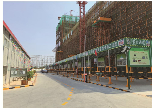
主干道现浇混凝土硬化
