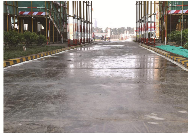
主干道定型钢板构件硬化
