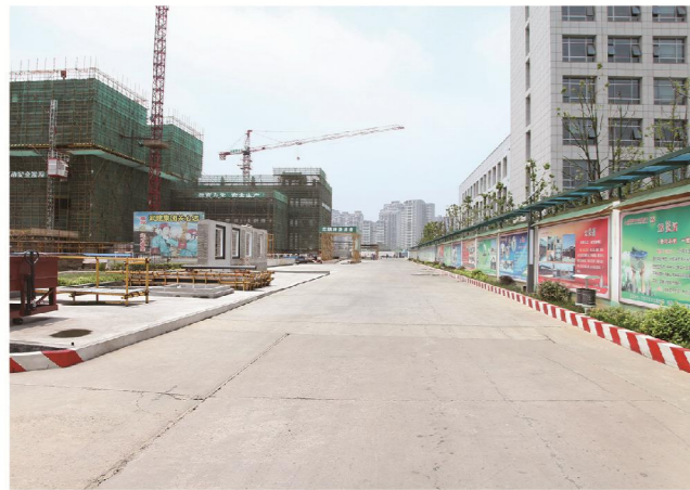
主干道现浇混凝土硬化
