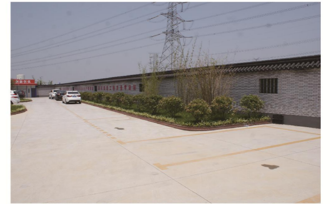
停车场地现浇混凝土硬化
