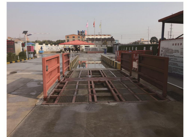
过水池+自动冲洗平台
