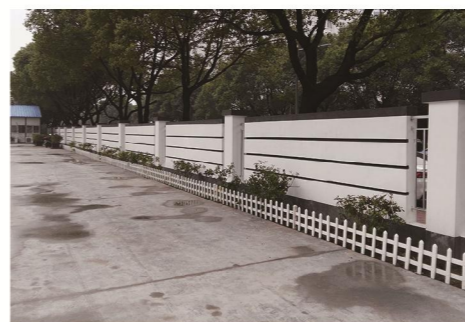
砖砌立柱、局部镂空墙体
