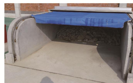
建筑垃圾防尘收集池
