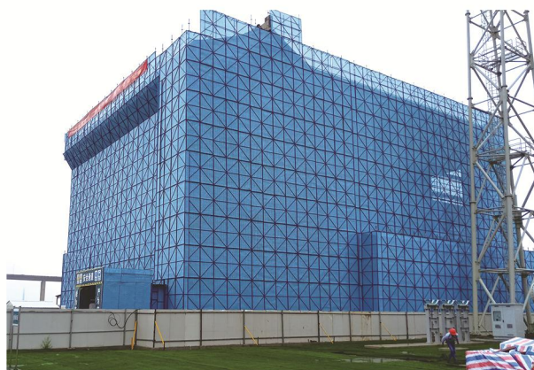
销键型脚手架架体、钢板网片围蔽
