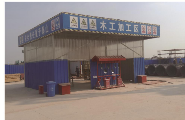
场地现浇混凝土硬化
