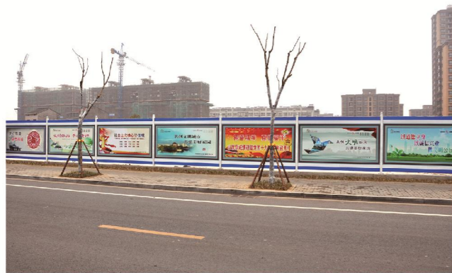
装配式围挡(型钢立柱、定型彩钢板墙体)
